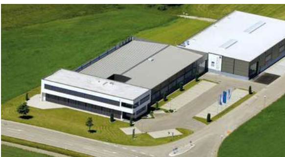
Usine Illmensee Systronik GmbH
