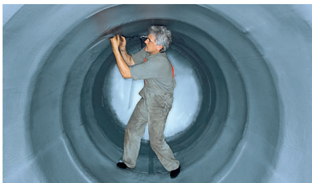
Pose de l'E.I.S.
